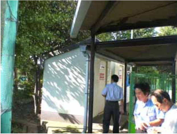
雨水貯留・浸透の専門家を交えての現地確認
